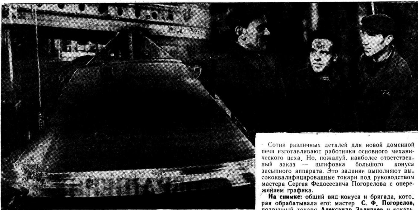
Сотни различных деталей для новой доменной печи изготавливают работники основного механического цеха. Но, пожалуй, наиболее ответственный заказ — шлифовка большого конуса засыпного аппарата. Это задание выполняют высококвалифицированные токари под руководством мастера Сергея Федосеевича Погорелова с опережением графика.
