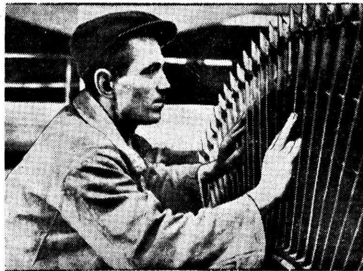
Слесаря-газосварщика центральной электростанции Николая Ивановича Кочергина товарищи по работе знают как хорошего специалиста. Он быстро и качественно ремонтирует оборудование. На снимке: Н. И. Кочергин проверяет бандажи лопаток ротора турбины. Фото Н. Пестеренко.
