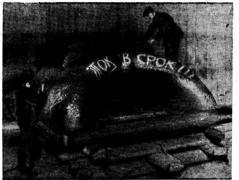
МОНТАЖ ПЕРВОГО АГРЕГАТА ЦЭС.
