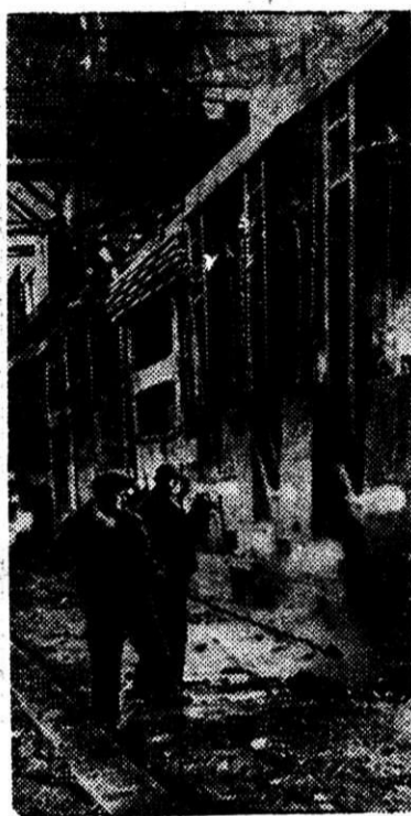
На рабочей площадке мартеновского цеха.
