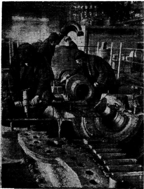
Бригада монтажников управления «Востокметаллургомонтаж» В. Д. Арзамасцева на сборке турбокомпрессора.
