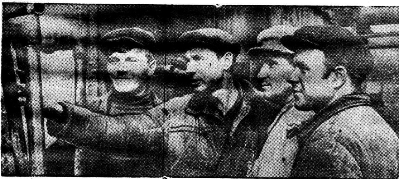
Слесари, механики, электрики доменного цеха вносят большой вклад в выполнение обязательств, принятых коллективом цеха на первый год девятой пятилетки. Своевременный и качественный ремонт обеспечивает бесперебойную работу оборудования.
