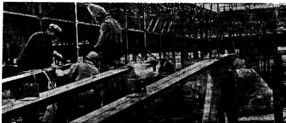
На снимках: общий вид строительства цеха гнутых профилей (вверху); мон- тажники управления Уралстальконструкции за работой.
