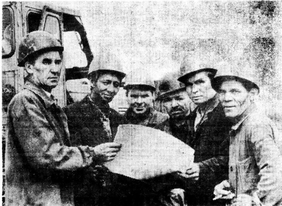
Успешно трудятся в четвертом году десятой пятилетки труженики строительно-монтажного управления комбината. Работая на различных участках реконструкции объектов комбината и на строительстве новых, коллектив досрочно выполняет задания.
