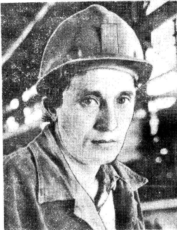
Коллектив второго цеха ремонта металлургических печей ведет ремонт нагревательных устройств прокатных цехов.
