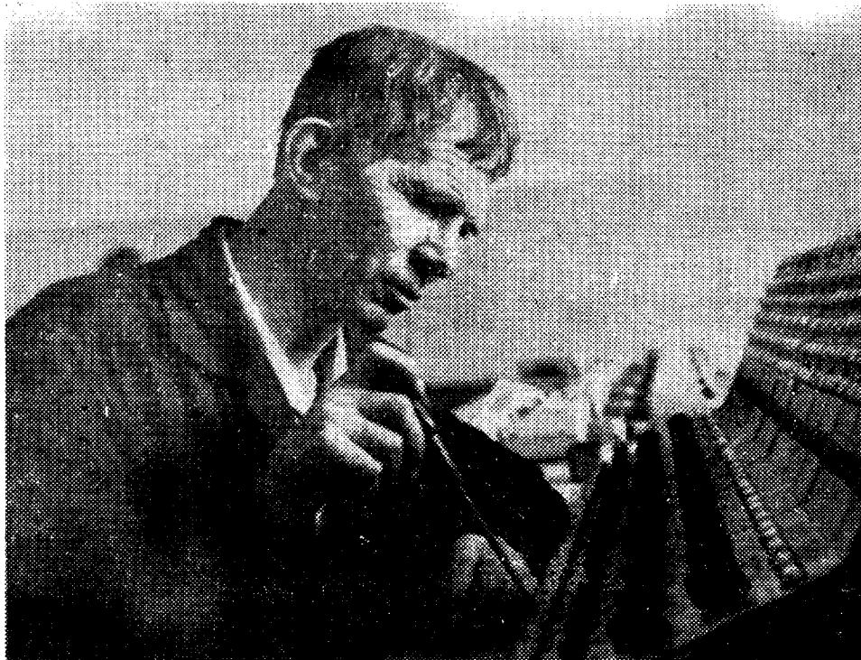
Боднев Николай Арсентьевич, которого вы видите на этом снимке, работает бригадиром электромонтеров в электромонтерном цехе мартеновских и прокатных цехов. Более тридцати лет трудится он в этом коллективе и является одним из передовых тружеников, которому поручаются особо сложные задания. Ударник коммунистического труда Н. А. Боднев всегда выполняет работы досрочно и с высоким качеством. Вот и сейчас ему поручено вести монтаж оборудования автоматизированного класса программированного обучения при отделе технического обучения.
