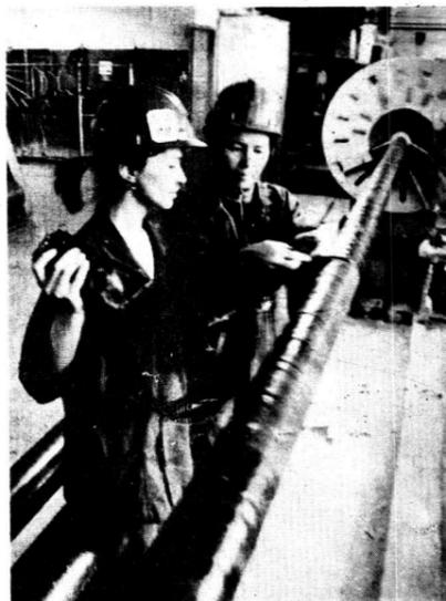
Только после довольно длительной обработки острым паром ролики готовы к отправке обратно в цех, где резиновую поверхность доводят на станках до идеальной ровности. После этого обновленными роликами и оснащаются агрегаты резки и травильные линии.
