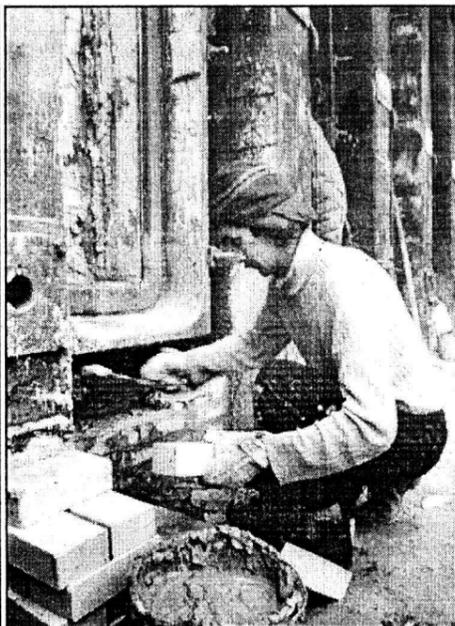
*В коксохимическом производстве завершаются работы на восстановлении и подготовке к вводу в эксплуатацию первой коксовой батареи. Напомним, что реанимация капитально отремонтированного и стоявшего в консервации агрегата началась 1 июня. Первоначально планировалось, что батарея вступит в строй действующих через полгода — 1 декабря.*
