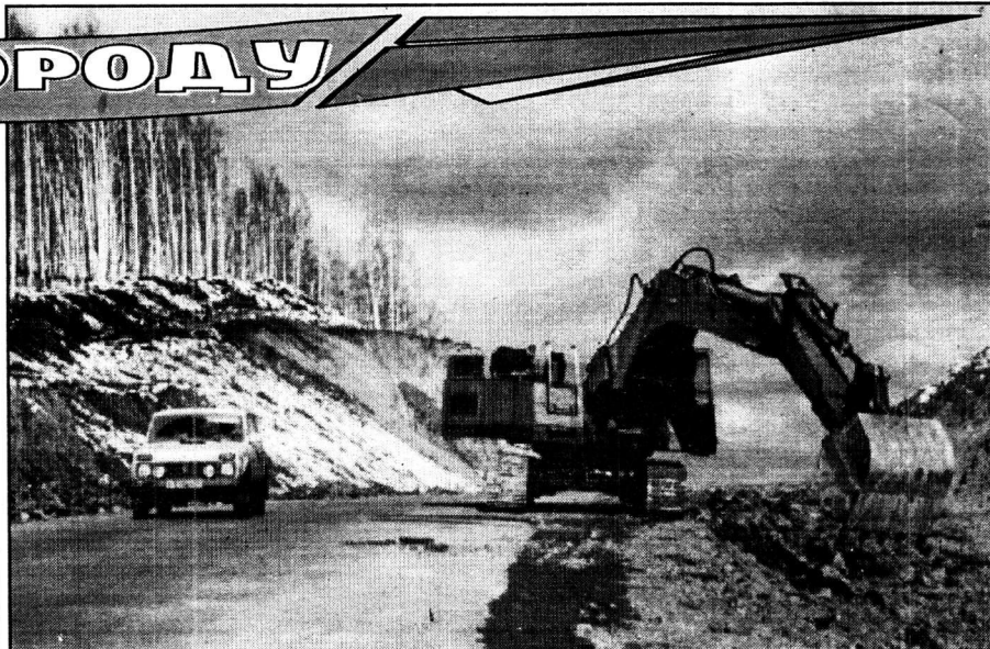
На строительстве дорог задействована мощная техника.
