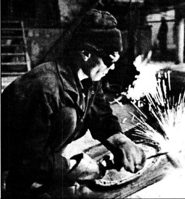
Завершение монтажа кислородного блока.
