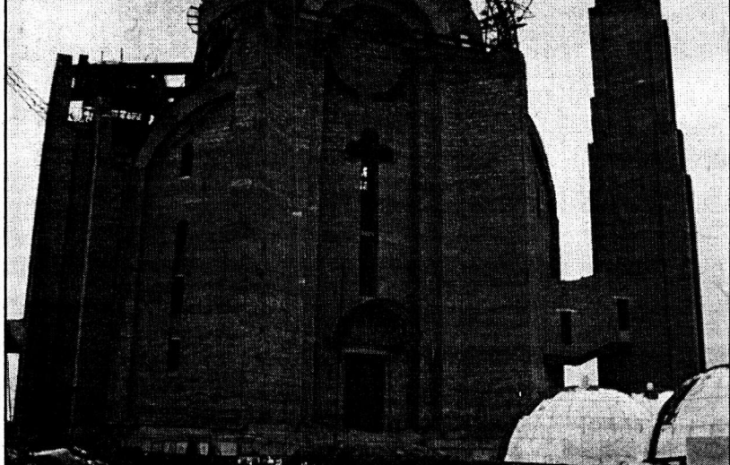
Июль 2000 года. На строительстве нового храма.
