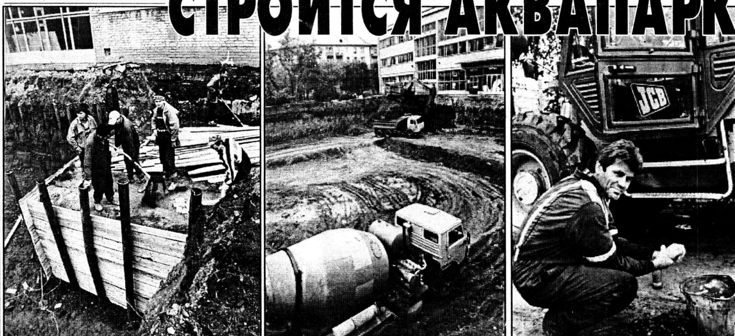
Работы на объекте в самом разгаре...
