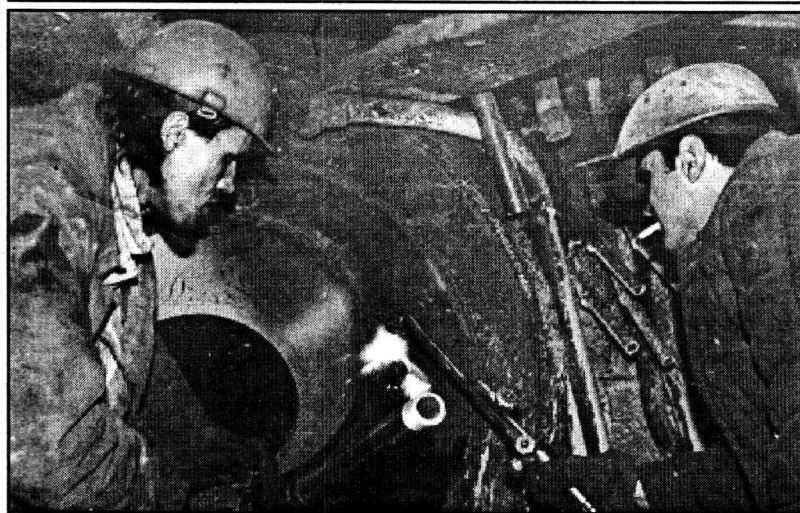
Идут сварочные работы.
