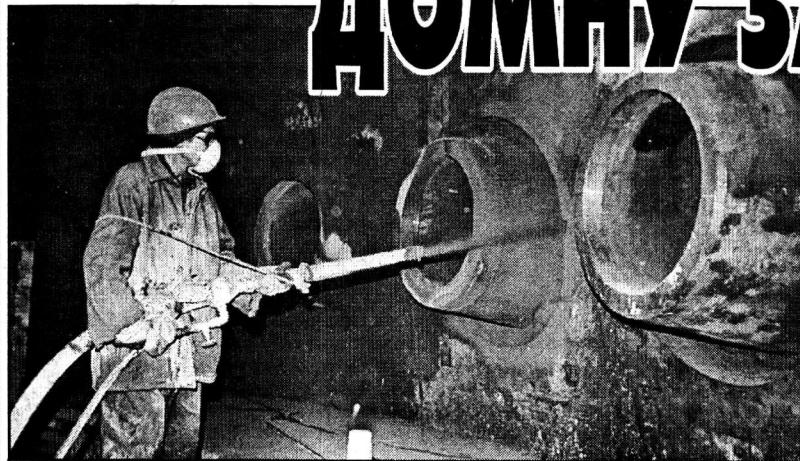
Подготовка домны к кладке кирпича.
