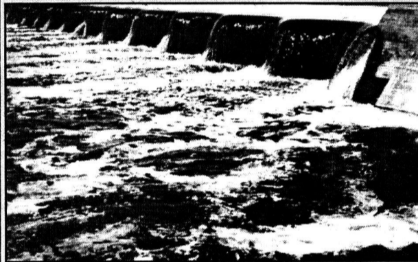
Слив первой плотины.
