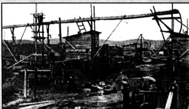
Котлован первой плотины.
