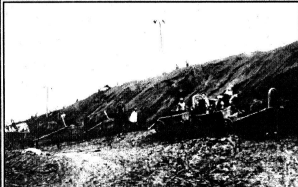
Строительство второй плотины.
