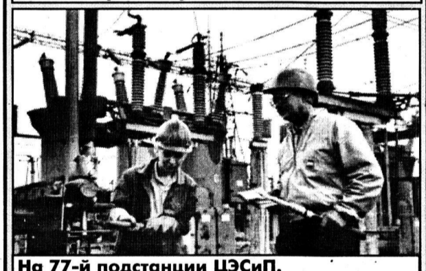
На 77-й подстанции ЦЭСиП.
