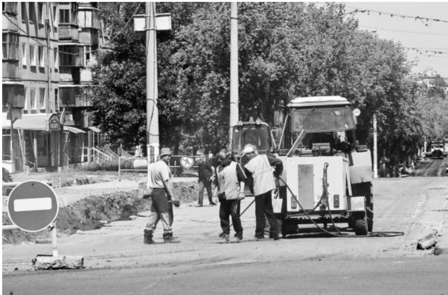
Ремонт проспекта Карла Маркса превратил ближайшие дворы в оживленные автострады
