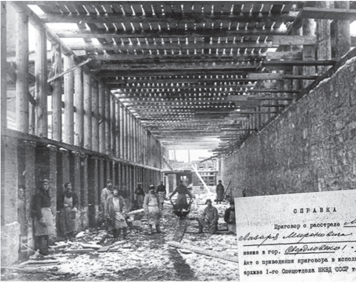
Строительство коксовой печи
