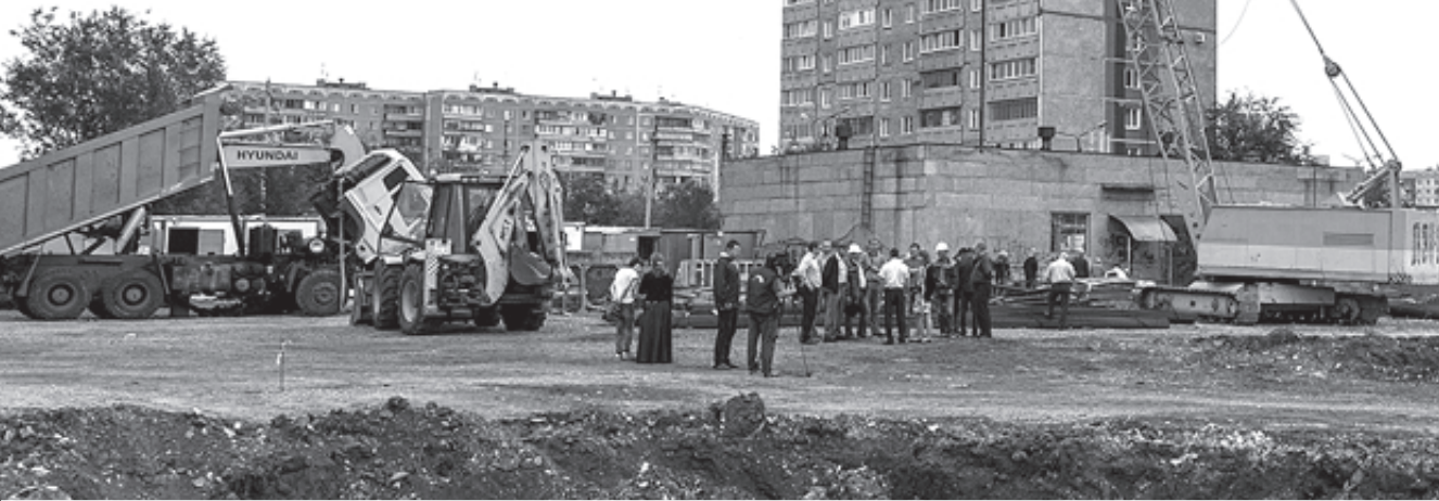
Строительство школы по улице Советской
