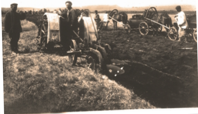
«Магнитострой». Земляные работы. 1929 г.
