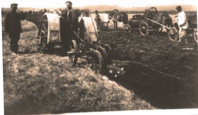
«Магнитострой». Земляные работы. 1929 г.
