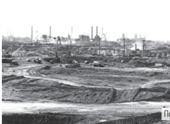
Вывоз шлака со строительной площадки, 1988 год
