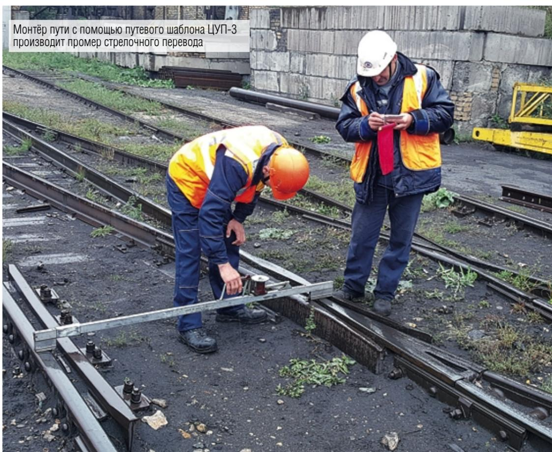
Монтер пути с помощью путевого шаблона ЦУП-3 производит промер стрелочного перевода
