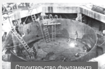
Строительство фундамента под первую домну
