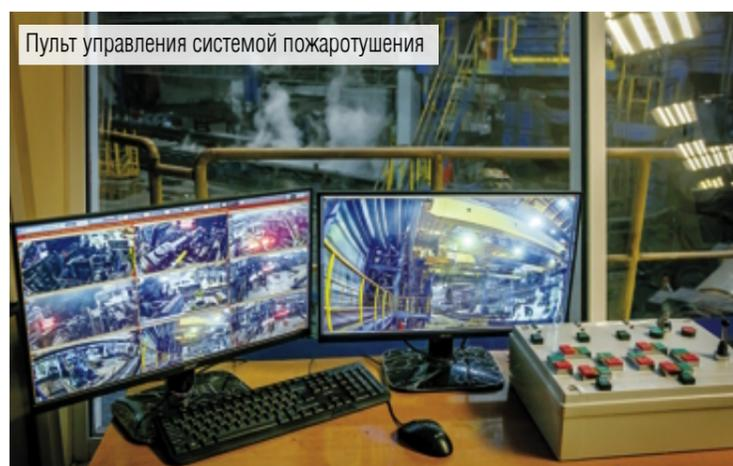
Пульт управления системой пожаротушения
