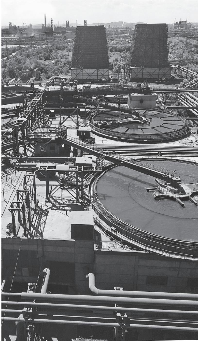
ротных циклах ККЦ в летний период. В результате металлургическое оборудование работает в установленных технологических параметрах, стабильно осуществляется технологический процесс, обеспечивая высокое качество продукции. Кроме того, в 2010 году на блоке очистных сооружений десятого листопрокатного цеха введены в работу два дополнительных радиальных отстойника.
