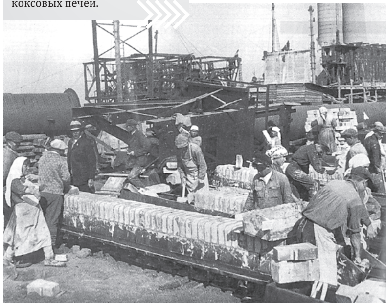
Коксовая батарея № 8 (футеровка дверей)
